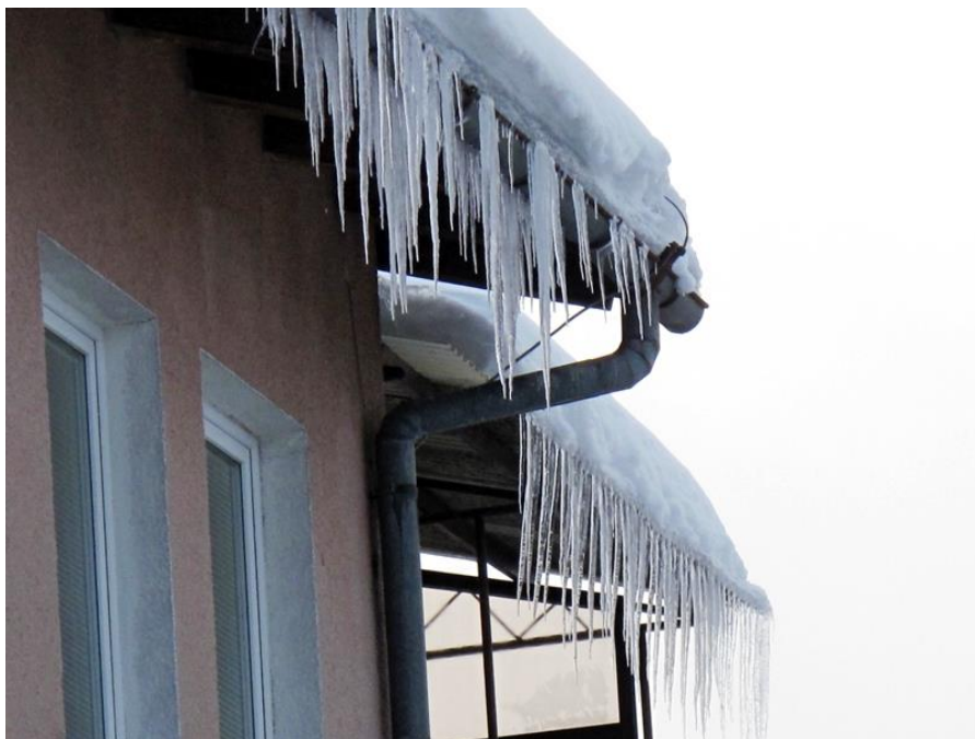
SLIKA 8: LEDENE SVEČE POKAŽEJO VELIKANSKE TOPLOTNE IZGUBE STAVBE, KI SO NEPOTREBNE. VELJA TUDI NASPROTNO. DOBRA TOPLOTNA IZOLACIJA STAVBE JE POGOJ ZA URE. VIR: HTTP://WWW.GRADIMZELENO.SI/WP-CONTENT/UPLOADS/2013/11/LEDENE-SVEČE.JPG .
